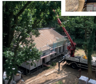
Baufortschritt des neuen Gebäudes in Potsdam
